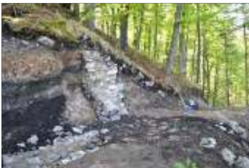
Sl. 2.11: T6. Predhodno pripravljena površina je bila končno nasuta s predhodno odstranjenimi zemljenimi depoziti iz z vlako porušenega dela stratifikacije. Stanje ob zaključku del (foto: A. Gaspari; DSC_5494)
