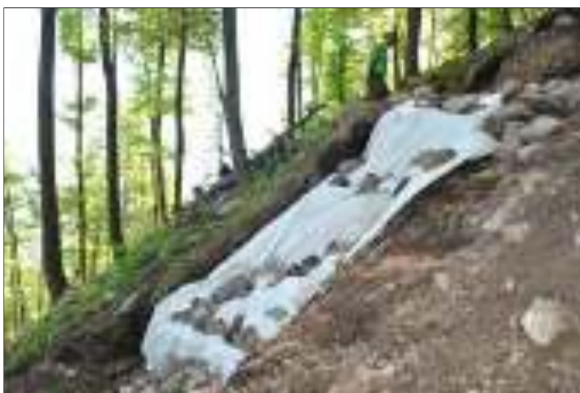
Sl. 2.9: Prekrivanje severozahodnega vogala obzidja na T6 z geotekstilom (foto: A. Gaspari; DSC_5490)
