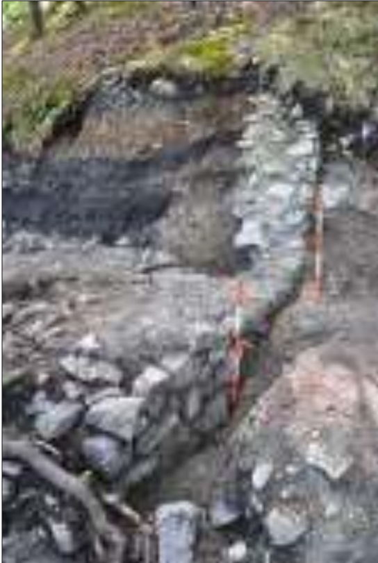
Sl. 3.13: T6. Vkopan del temelja (desna trasirka) in začetek zaglajenega lica zahodne stranice obzidja. Pogled proti jugovzhodu (foto: A. Gaspari; DSC_5385)
