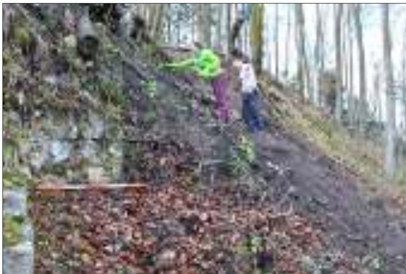
Sl. 2.2: Čiščenje poškodovanega dela severnega dela obzidja na T1 (foto: A. Gaspari; DSC_5358)
